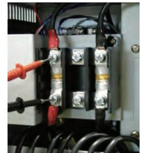
② 切れているものを新品と交換し、内部配線と一緒にねじでしっかりと固定します。
