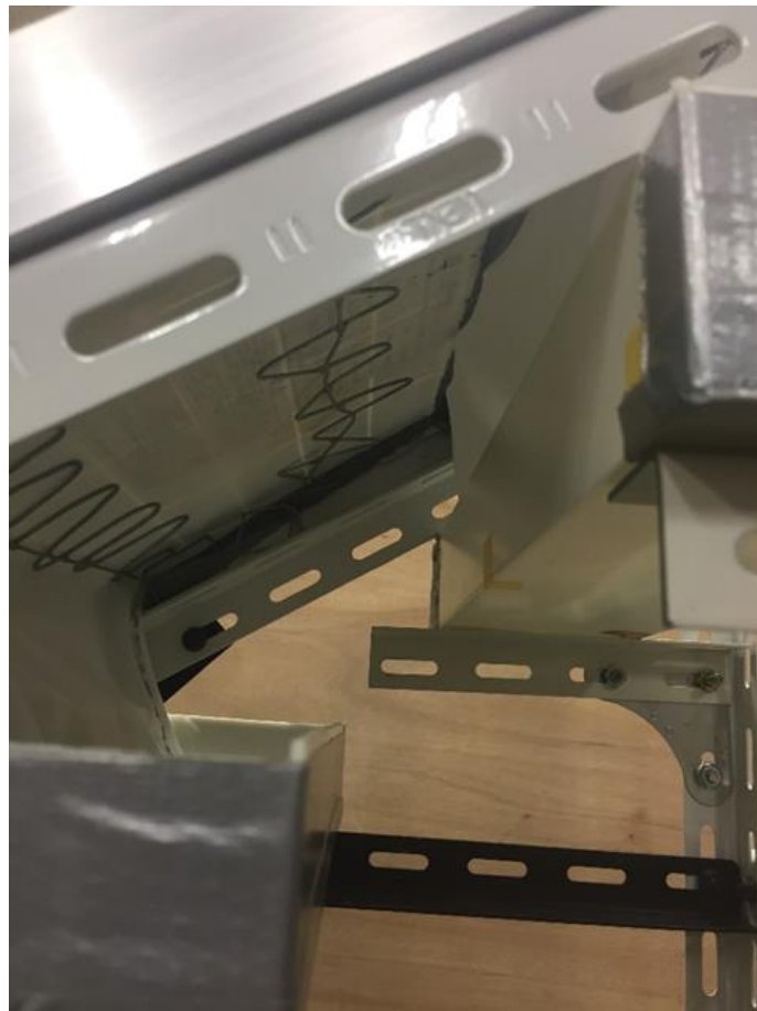
Fig. 18 パネル裏面の様子
