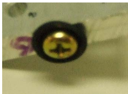
図 2.14 パッキン 2—連結板間
