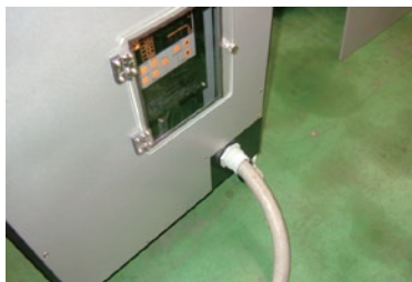
参考写真：取付後
