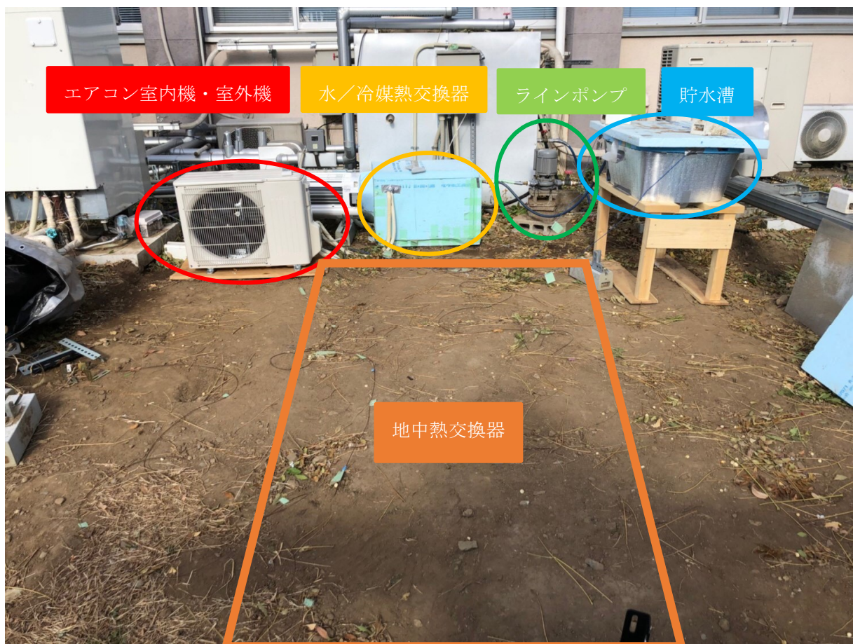
Fig.3 地中熱ヒートポンプシステム
