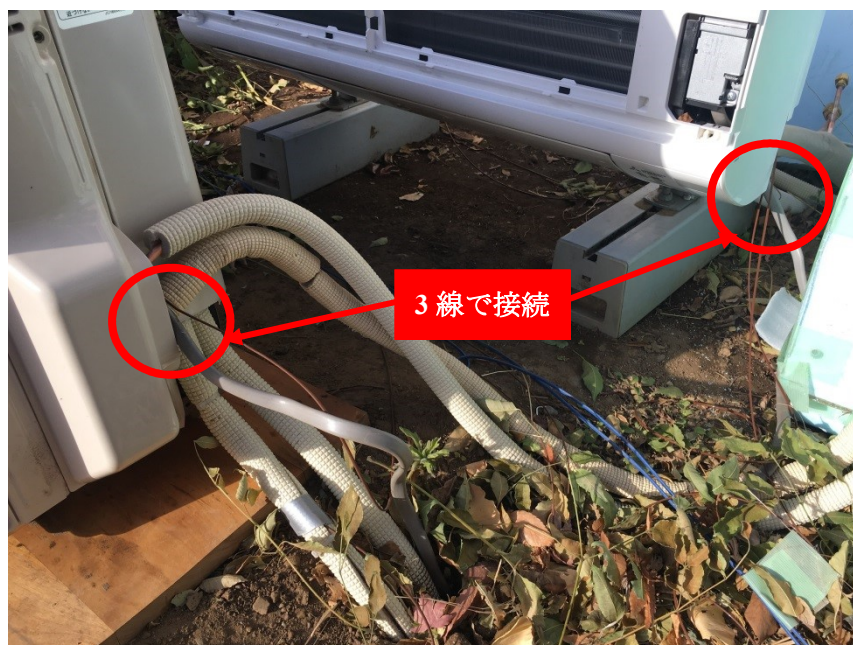
Fig. 4 室内機と室外機の接続
